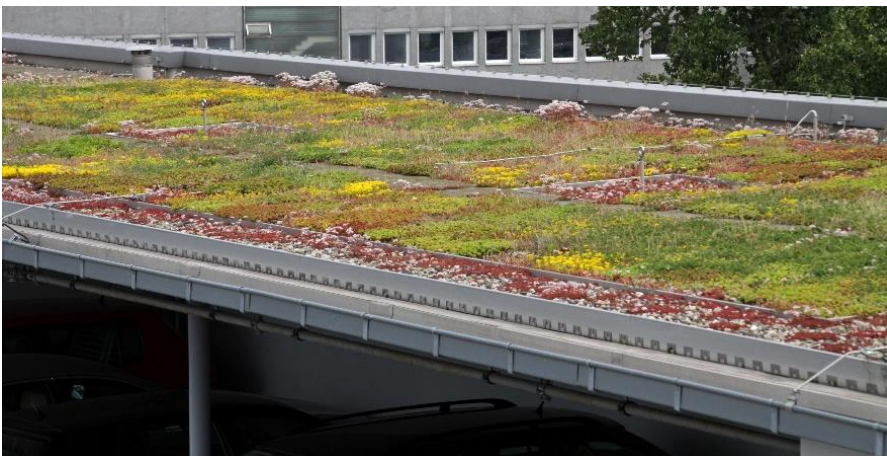
Abb. 5 zu 2.5., 2.6.: Beispiel für begrüntes Carport / Tiefgaragendach
